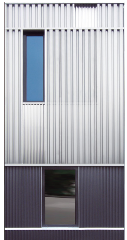
Bahnhof Wien West - Österreich, Aluform Trapezprofil 45/150 blank glatt, gelocht
