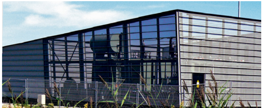
Erdgasbuffering Zuiderwending - Holland, Aluform Stehfalzprofil 64/400 gelocht
