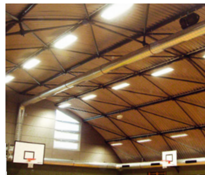
Gymzaal Winzerla - Duitsland, Aluform golfprofielplaat 55/177 geperforeerd met akoestisch folie en getoogd
