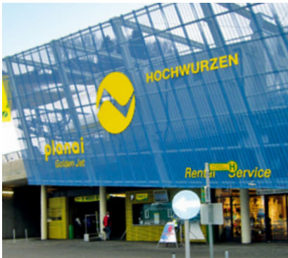
Skistation Planai - Oostenrijk, Aluform golfprofielplaat 55/177, geperforeerd
