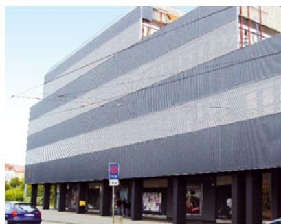
Karstadt Halle - Duitsland, Aluform golfprofielplaat 18/76, geperforeerd en niet geperforeerd
