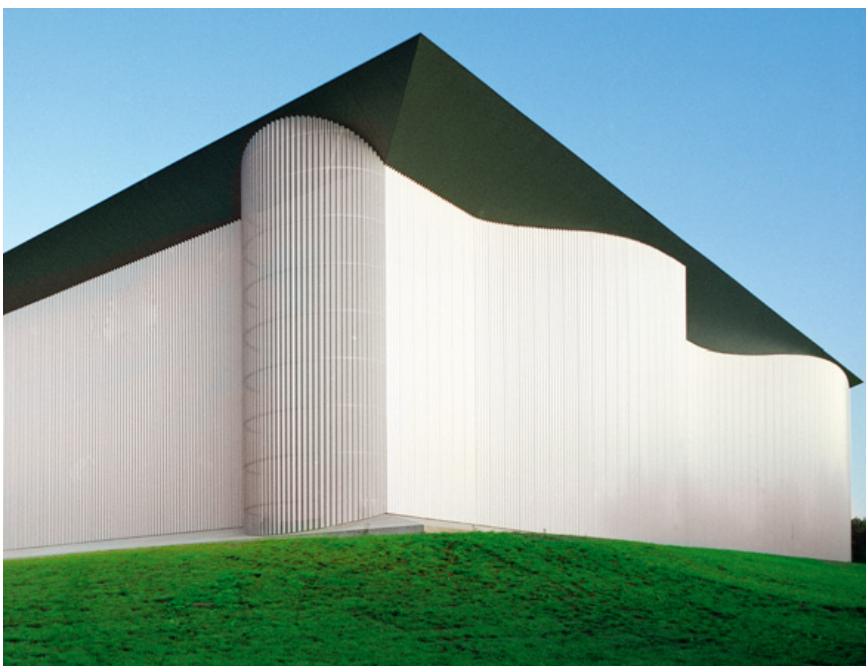
Ernsting's family, Verzorgingscentrum, Klieken Aluform golfprofielplaat 55/177, geperforeerd
